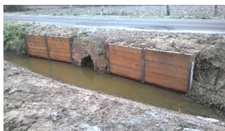
Rue des Fusillés : renforcement de la berge
