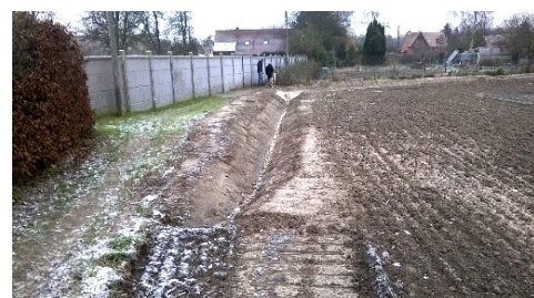
Rue J. Jaurès : reconfiguration de la collecte des eaux de ruissellement et évacuation à un exutoire
