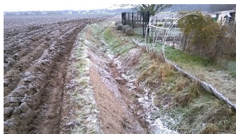
Rue Guesquière : reconfiguration de l'exutoire
