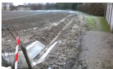
Rue J. Jaurès : reconfiguration de la collecte des eaux de ruissellement et évacuation à un exutoire
