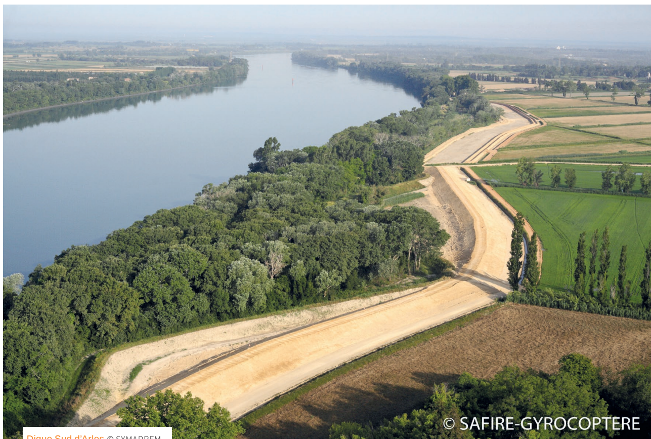
Digue Sud d'Arles © SYMADREM
